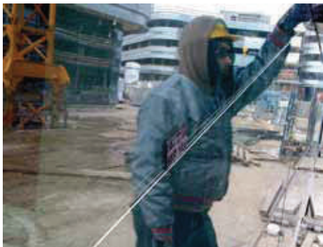
Verifica della freccia d'inflessione.
