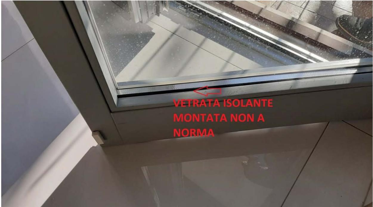
E' probabile che il "caricamento" del vetro per il giusto funzionamento dell'anta battente ed a ribalta non sia stato effettuato con i criteri della norma UNI EN 12488 Posa del vetro in edilizia già UNI 6534 e secondo la perfetta regola d'arte,ciò è verificabile allo smontaggio del vetrocamera stesso.
