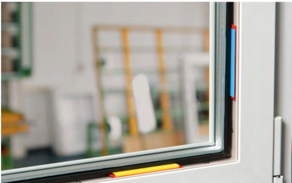
Tassellatura tipo C1 e C2, sullo spigolo basso lato cerniera, per la posa in opera a perfetta regola d'arte delle vetrate isolanti su telaio apribile a battente
