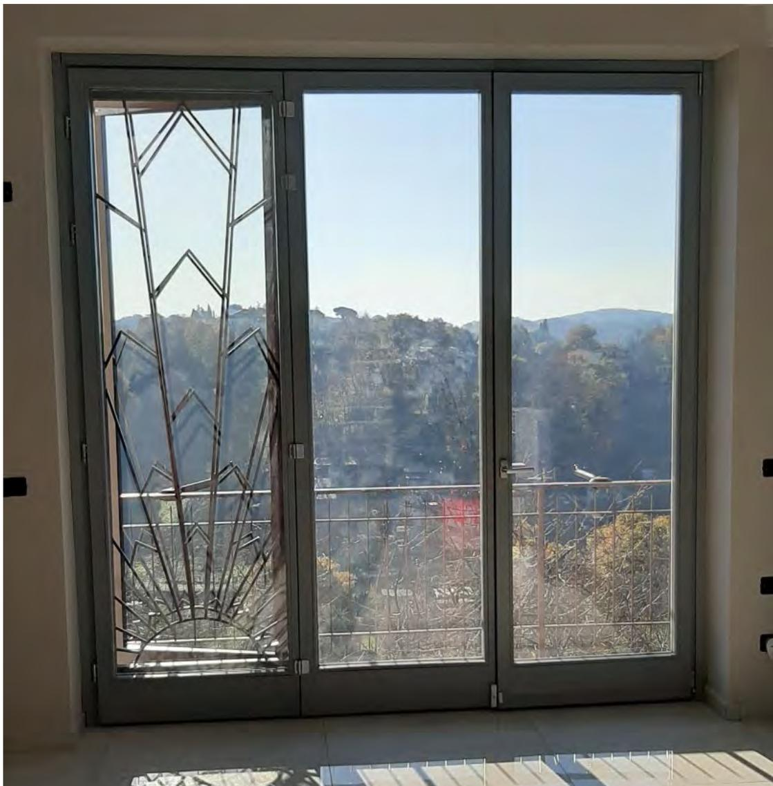
Il serramento analizzato presenta varie imperfezioni, ovvero l'anta apribile a battente sulla destra del serramento, con il punto di osservazione dall'interno del soggiorno, è collocata in modo disallineato rispetto alle altre ed inoltre fuori piano (vedi foto).
